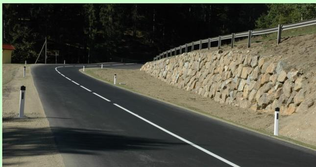
Straßenunterbau und Entwässerung wurden neu errichtet, die Böschungen angepasst, die Hauszufahrten und die Einmündung der Güterwege verbessert und die Fahrbahn spürbar verbreitert.
