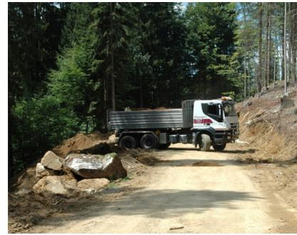
Die Seitenentnahmen sind über die gesamte Länge des Bauabschnittes bereits abgeschlossen. Für ein Teilstück davon ist auch die Asphaltdecke schon gefräst, sodass in diesem Bereich an der Errichtung der Oberflächenentwässerung gearbeitet wird und die Schotterungsarbeiten erfolgen können.
