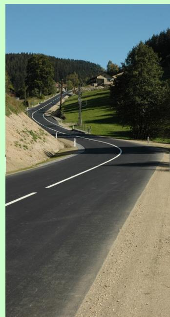
Insbesondere im Bereich der Einbindung des Güterweges Hagen konnten durch die Errichtung einer Steinschlichtungsmauer die Sichtverhältnisse deutlich erhöht werden.
