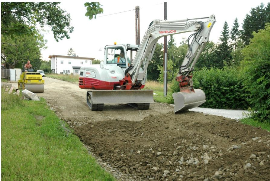
natürlich - so wie in der Vergangenheit auch - im Zuge des Bauvorhabens durch die Firma Elektro Pühringer GmbH die Leerverrohrung für Glasfaser-Internet mitverlegt und durch das Unternehmen Ebner Strom GmbH die Niederspannungs-Stromleitungen durch Erdkabel ersetzt. Die Abstimmung zwischen Gemeinde, Anrainern, Energieversorger, Internet-
