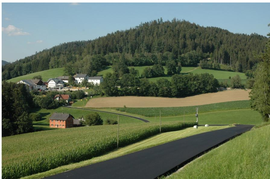
weg Unter St. Georgen bis zur Gemeindegrenze zu Dimbach - die bestehende Fahrbahn profiliert und anschließend mit einer neuen Asphaltdecke versehen. Anders als bei den Arbeiten der vergangenen Jahre an den Güterwegen Ottenschlag und Ebenedt war diesmal der Unterbau in ausreichendem Maße vorhanden. Die ursprüngliche Absicht, die bestehende Brücke über den Vogelsammühlbach in der Ortsmühle (Hillinger) ebenfalls „nur“ zu sanieren, musste man-
